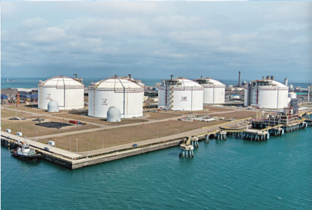
圖 3 中油台中液化天然氣接收站液化天然氣儲槽
