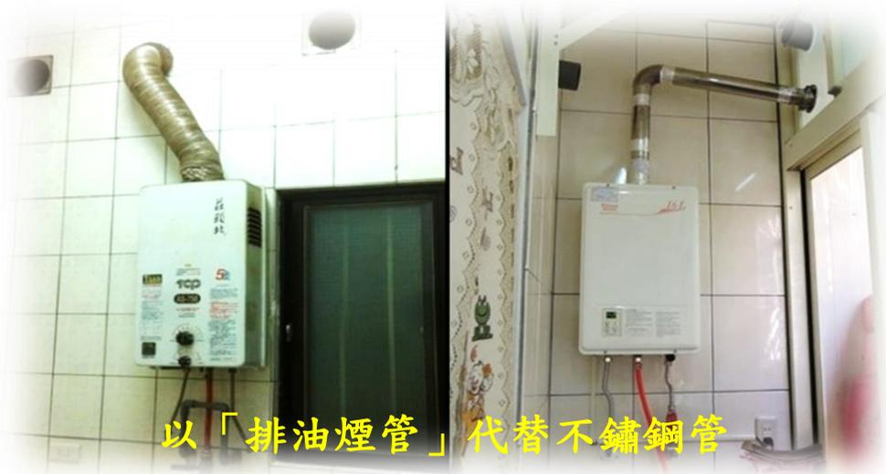
以「排油煙管」代替不鏽鋼管
