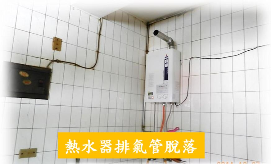
熱水器排氣管脫落
